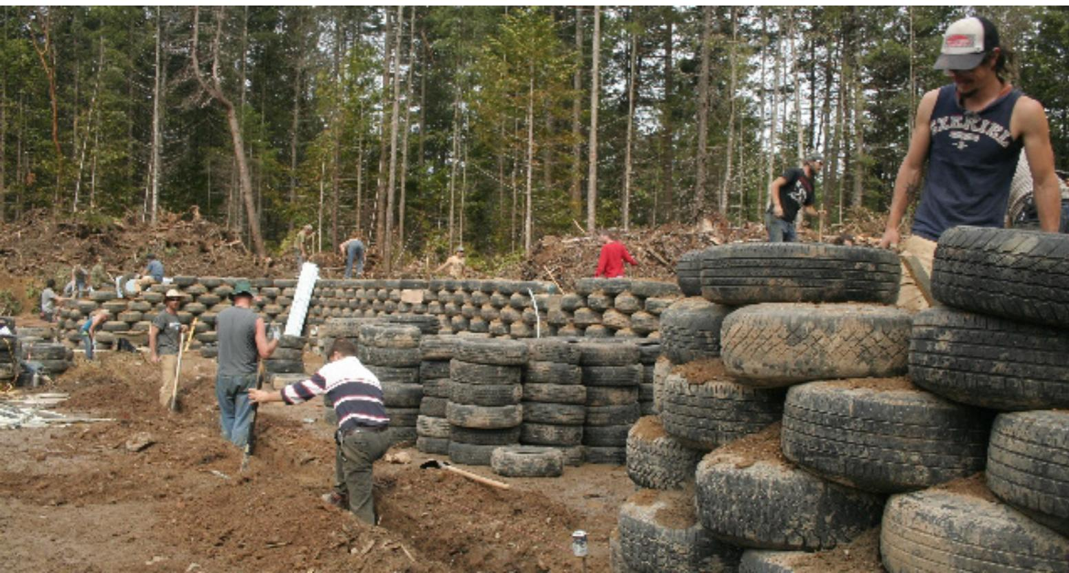
**E**arthship objekti se dizajniraju da funkcionišu kao autonomni objekti koristeći konstrukciju kao termičku masu i prirodnu poprečnu ventilaciju za regulisanje unutrašnje temperature. Oni su uglavnom vanmrežni objekti, odnosno nisu priključeni na elektro distributivne i javne komunalne mreže.
